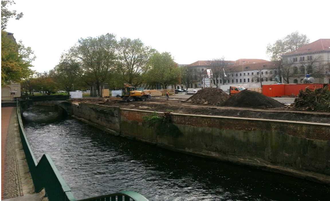
Abb. 41: Bauarbeiten im Oktober 2013 auf dem Areal der früheren Leineinsel im Rahmen von Hannover City 2020+ (eigenes Foto)
