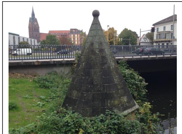
Abb. 19: Der Sielturm am Friederikenplatz, im Hintergrund die Marktkirche (eigenes Foto)
